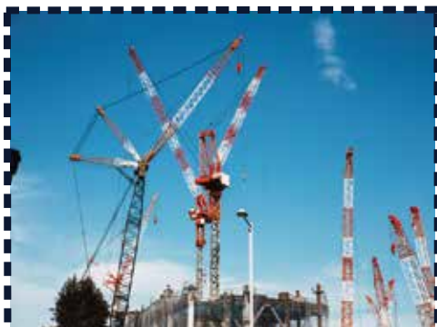
クレーン作業現場
