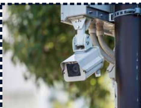
防犯カメラ設置工事
