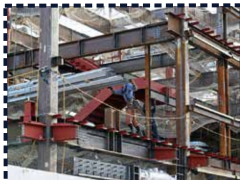
高所作業現場
