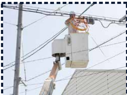
電気や電話・LANの配線設置工事
